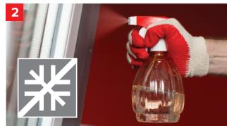
Рекомендуется увлажнить поверхность водой для улучшения сцепления пены. Пену нельзя наносить на поверхность, покрытую инеем или льдом!
