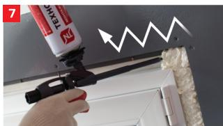
Заполняйте швы равномерными W-образными движениями, оставляя для расширения пены примерно 1/3 объема заполняемой полости.
