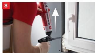
При заполнении вертикальных щелей пену наносят снизу вверх (в таком случае еще жидкой пене будет на чем держаться).
