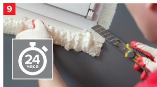
Процесс полной полимеризации пены составляет 24 часа. После этого удалите излишки пены и установите откосы.
