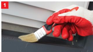
Очистите поверхность при помощи мягкой щетки или кисти. Для удаления жировых загрязнений используйте ветошь, смоченную очистителем монтажной пены ТЕХНОКОЛЬ.
